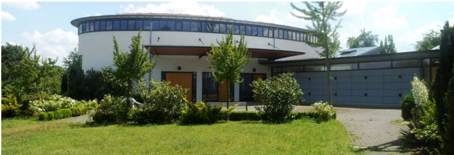
Aussegnungshalle oberer Friedhof Sielmingen Außenansicht
